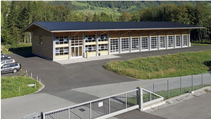
Abbildung 30: Neuer Forstwerkhof Chilcherli
